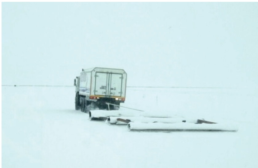
Рис. 5. Утрамбовка полотна трубами-волокушами. СЛД «Аксарка — Яр-Сале». Апрель 2018. Фото автора
